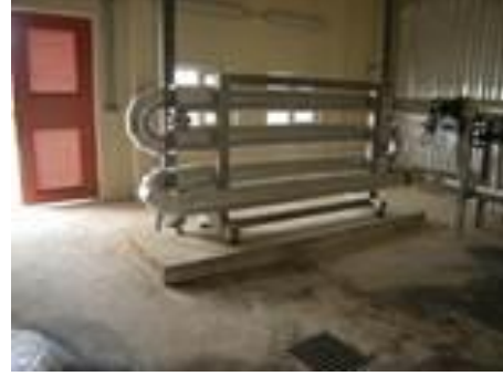
Şekil 4. Eşanjör (çift boru) Figure 4. Heat exchanger (double pipe)
